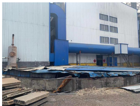
事故水池加盖防雨罩
